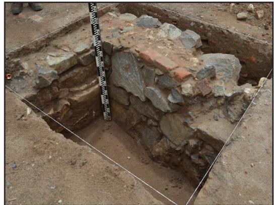
Figura 9. Detalle de muro fundación de mampostería de piedra unida con argamasa de arena y cal. Unidad 74.
