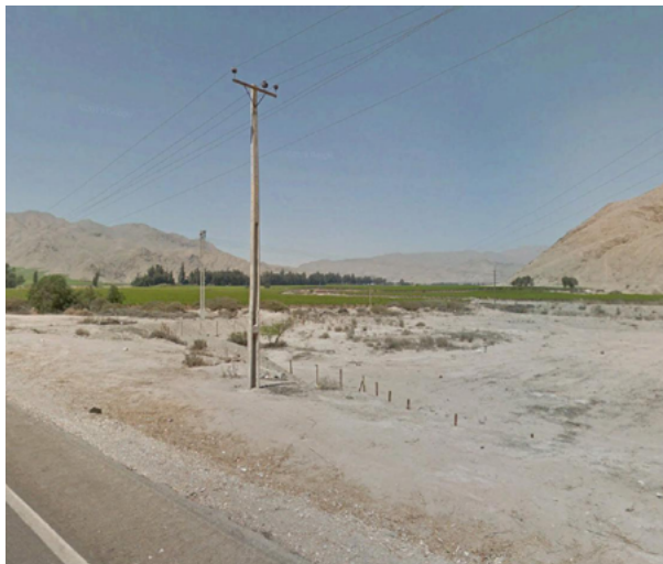
Figura 3: Vista General del cruce C-35 año 2012. Fuente: Google Earth.
