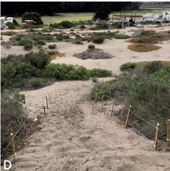
D, E, F, G, H, I. Fotos del proceso constructivo del prototipo.
