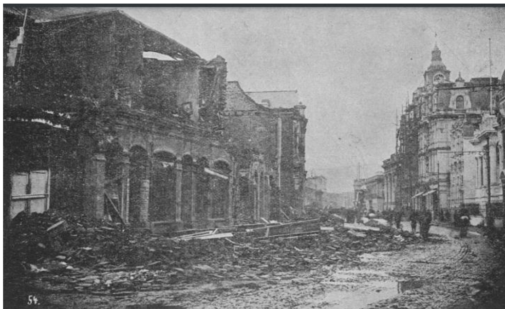
Calle Condell después del terremoto 1906, se puede apreciar el palacio Lyon en pie sin mayores daños 12
